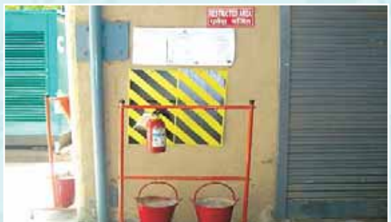
Fire-Fighting Equipment अग्निशमन यंत्र
